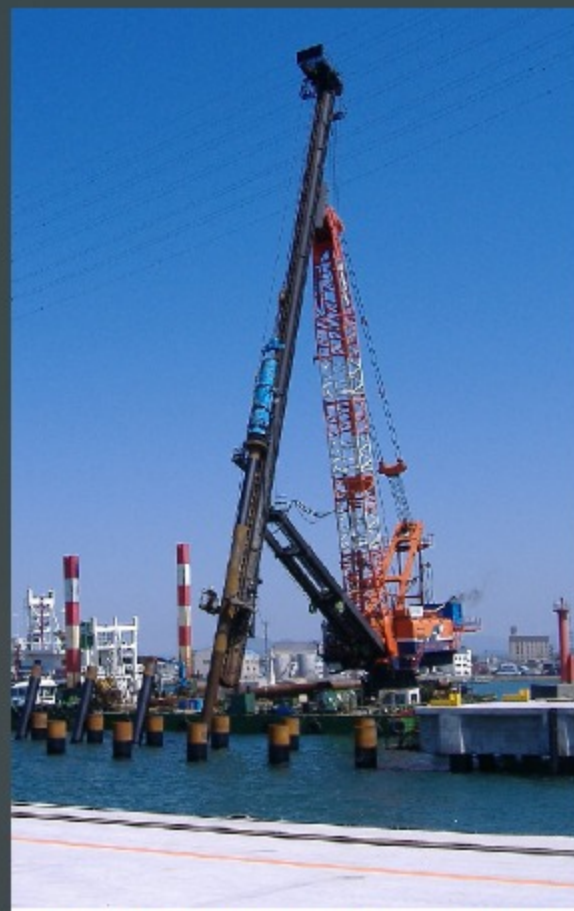
鋼管杭打設(油圧ハンマー 斜20度)
