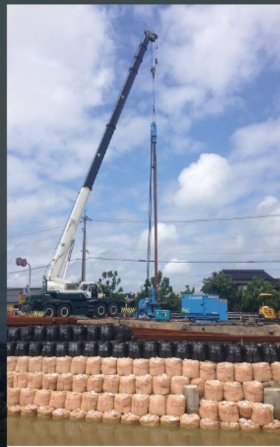
鋼矢板打設(クラッシュパイラー工法)
