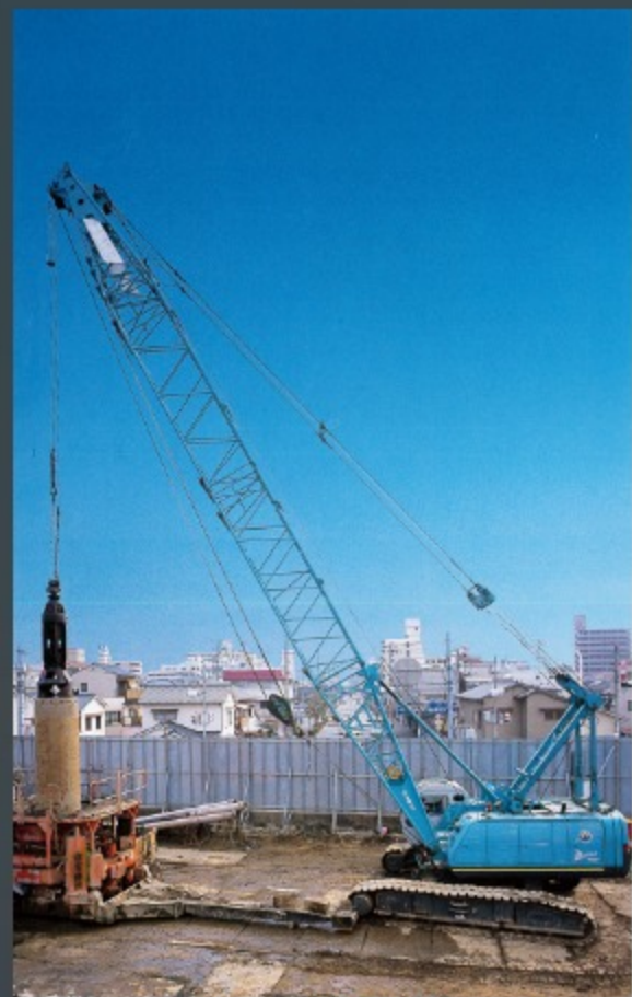
オールケーシング現場杭
